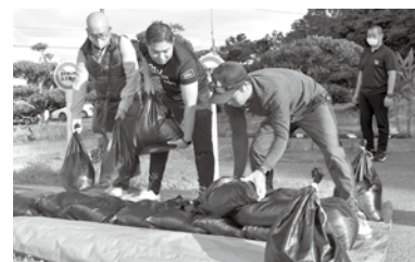
土のう積みの実践 コツは「袋の口を下に折り込み、水が袋の中に入らない用にすること」です。
