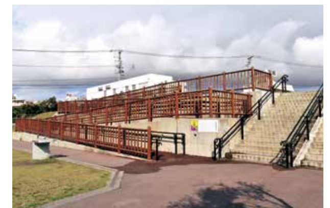
ウガンタ前公園(字宮平)スロープ
