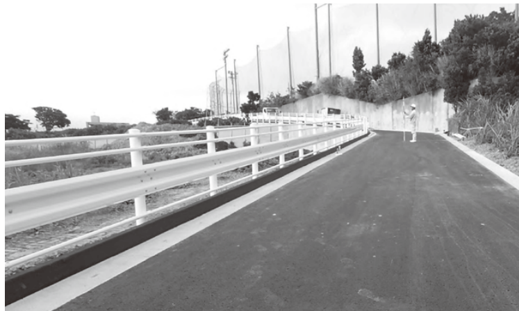
津嘉山小学校南側避難通路
