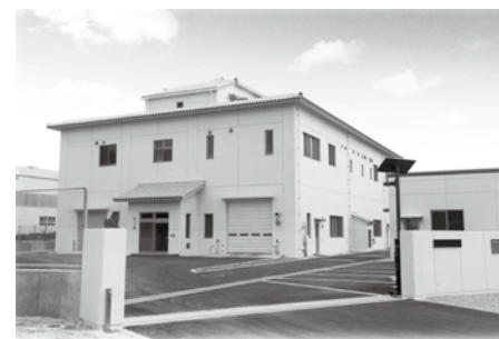
完成した汚泥再生処理センター
