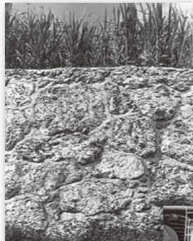
穴埋めされた石積み
