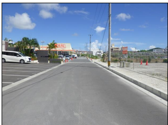
●区9-11道路整備状況(津嘉山1509番地付近)
