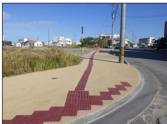
●本部公園線歩道整備状況(津嘉山537番地付近)
