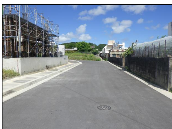
●区9-6-2道路整備状況(津嘉山495番地付近)
