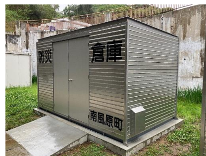
▲整備した備蓄倉庫
