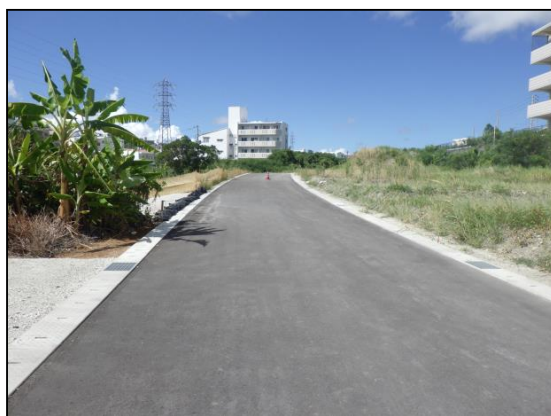
●区6-50-1道路整備状況(津嘉山1436-3番地付近)
