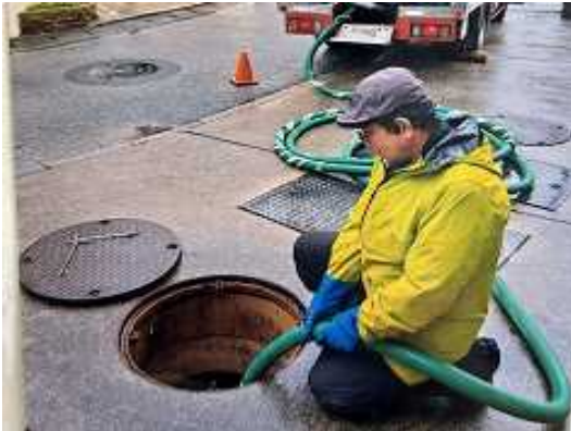
↑ 浄化槽の清掃の様子
