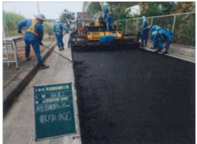
▲町道の舗装修繕作業状況
