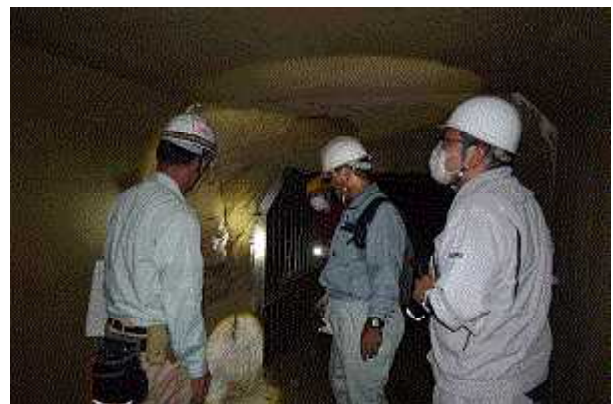
壕内部設備点検の様子
