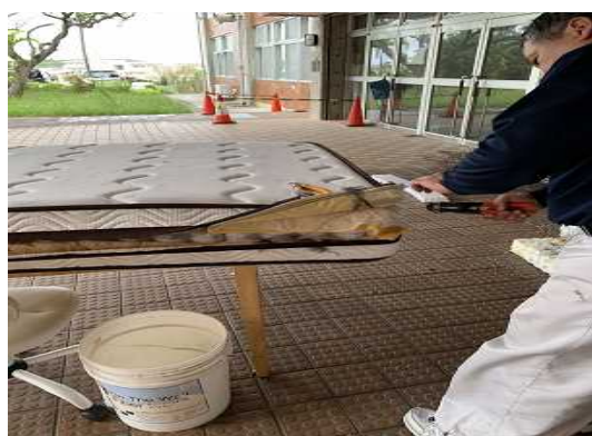
↑ マットレス解体作業の様子
