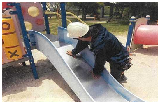
公園遊具の点検状況
