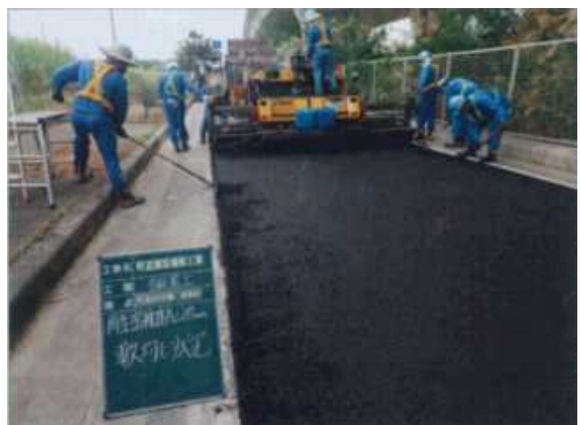
▲町道の舗装修繕作業状況
