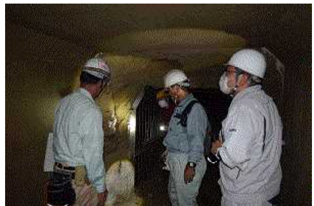
壕内部設備点検の様子
