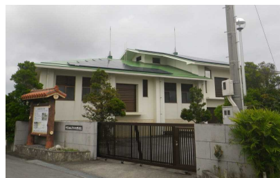
▲神里地区農業集落排水処理施設
