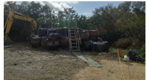
▲強固な不発弾処理用防護壁 (ライナープレート)
