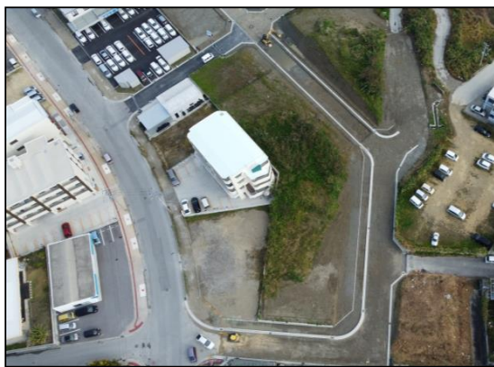
●69街区整備状況(津嘉山493番地付近)
