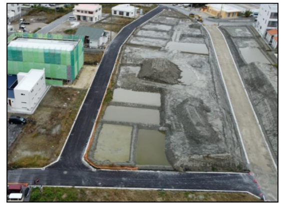
●97街区整備状況(津嘉山553-4番地付近)
