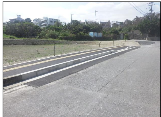
●区9-3道路歩道整備状況(津嘉山1377-3番地付近)
