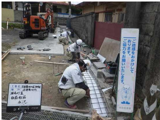
▲町道の排水溝及び舗装の修繕作業状況
