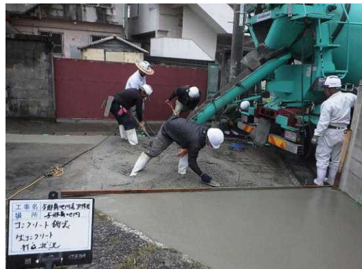
▲町道の排水溝及び舗装の修繕作業状況
