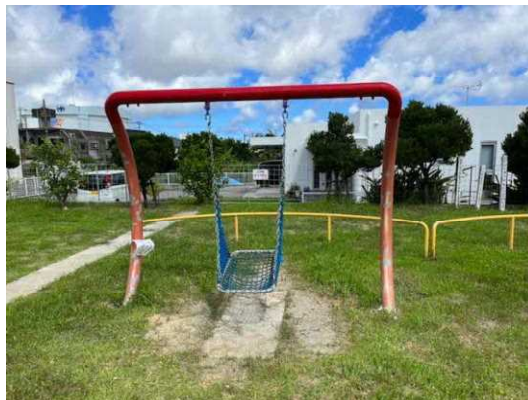
▲公園遊具の修繕作業状況
