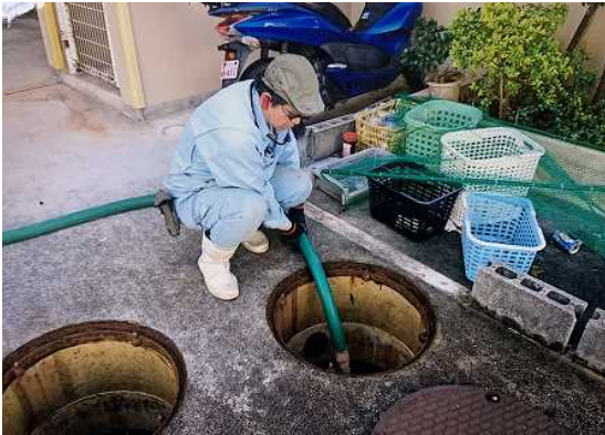
↑ アパートの合併浄化槽を清掃しています
