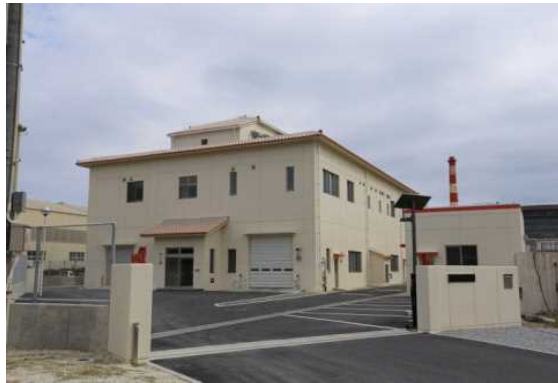
↑ 汚泥再生処理センター（西原町字小那覇964番地）
