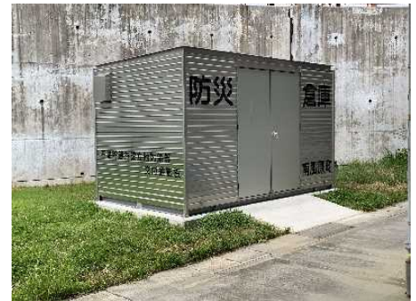
▲令和3年度に整備した防災倉庫
