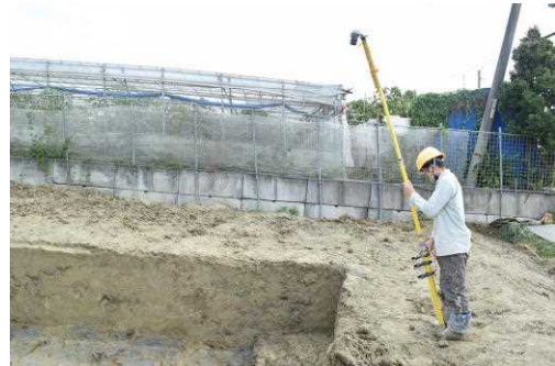
記録作業(写真測量)の様子
