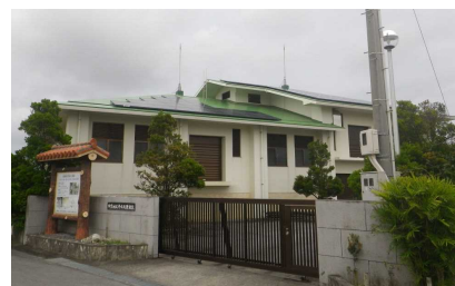
▲神里地区農業集落排水処理施設
