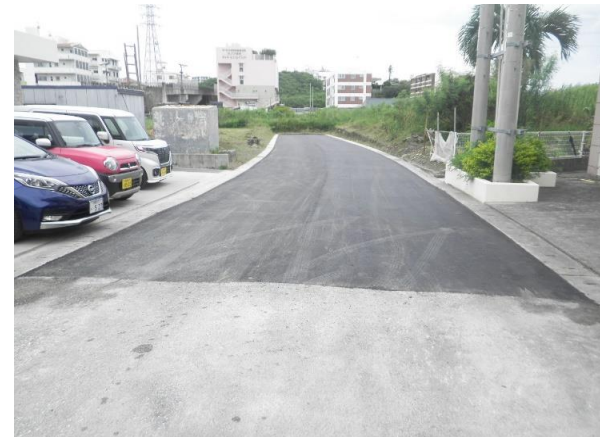
●津嘉山1177番地周辺 工事完了
