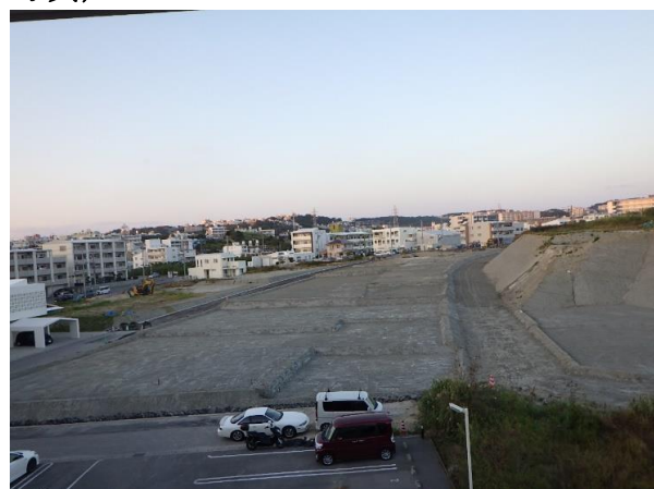
●旧津嘉山ハイツ周辺 工事中
