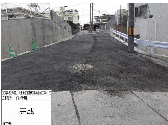
●津嘉山1397番地周辺 工事完了
