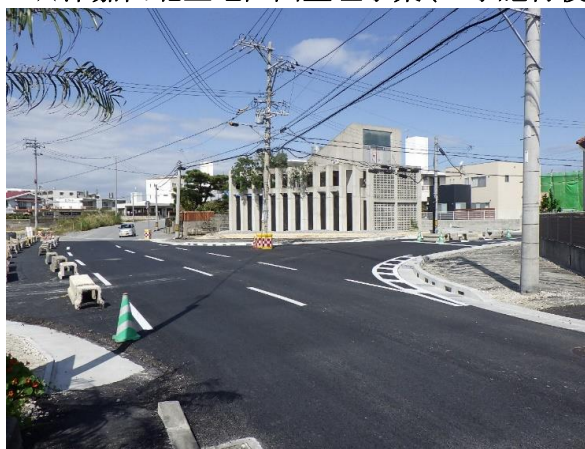
●本部公園線 工事中
