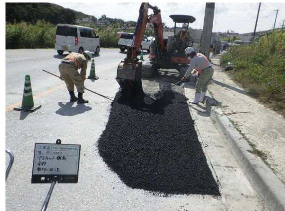
▲町道の劣化したアスファルト舗装の補修作業状況
