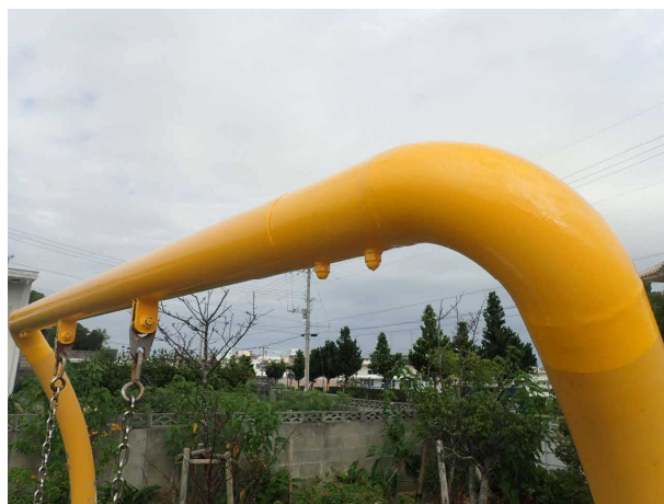
▲公園遊具の修繕作業状況
