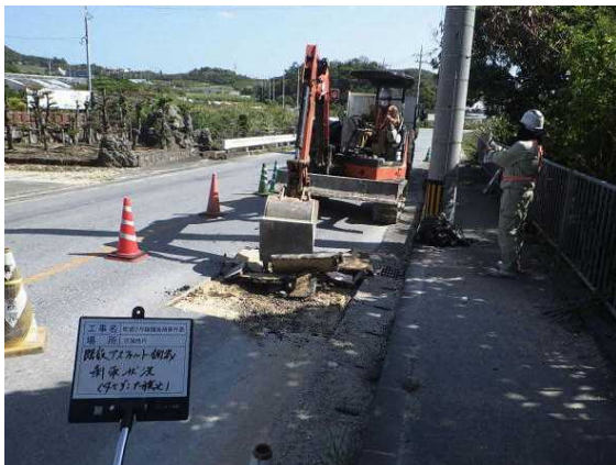
▲町道の劣化したアスファルト舗装の補修作業状況
