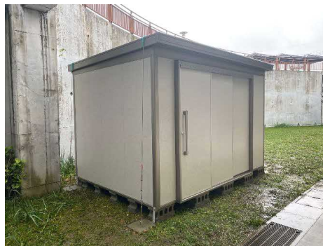
▲令和2年度に整備した備蓄倉庫
