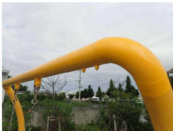
▲公園遊具の修繕作業状況
