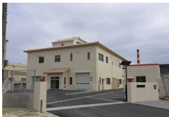
↑ 汚泥再生処理センター（西原町字小那覇964番地）
