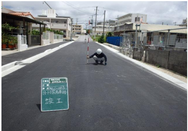
●津嘉山585番地周辺 工事完了
