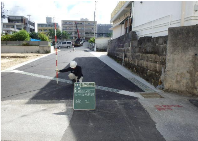
●津嘉山421番地周辺 工事完了
