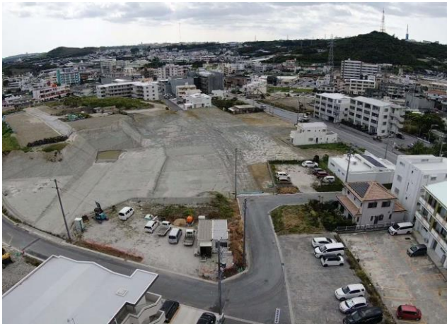
●旧津嘉山ハイツ周辺 造成工事中
