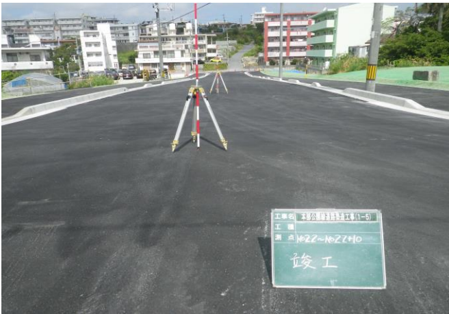
●本部公園線 工事完了
