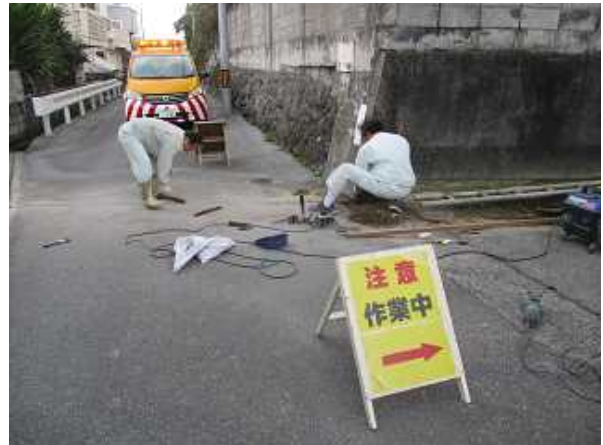
▲道路の排水補修作業状況
