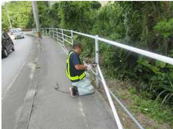
▲破損したガードパイプの補修作業状況
