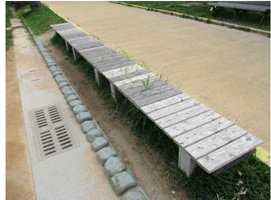
▲神里ふれあい公園ベンチ修繕状況
