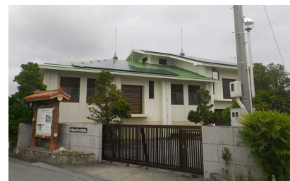
神里地区農業集落排水処理施設▲
