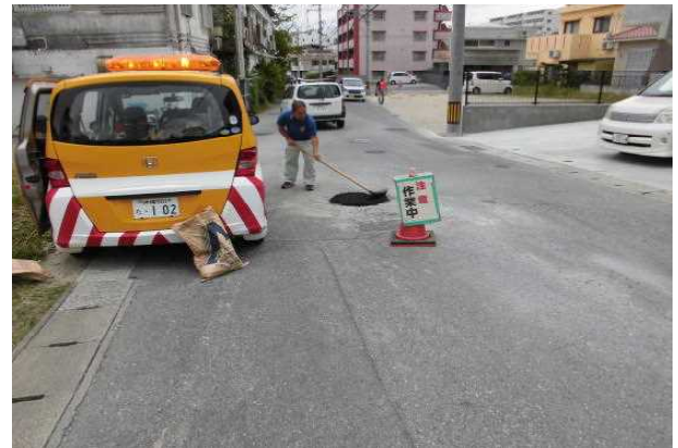
▲道路の補修作業状況
