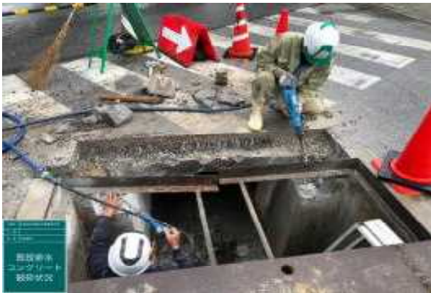
▲破損した排水溝の補修作業状況
