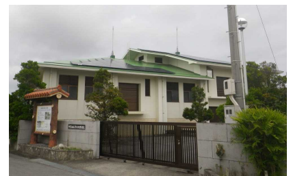
神里地区農業集落排水処理施設▲
