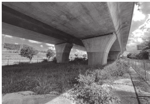
現在的那覇空港自動車道桁下空間
