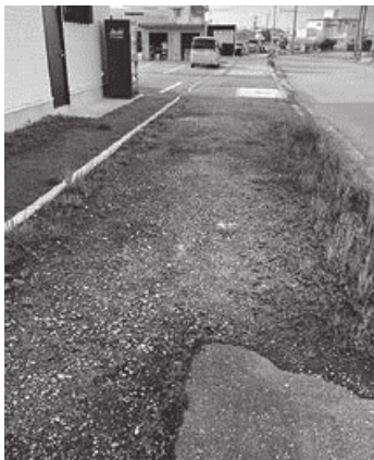
町道290号線 歩道現状
