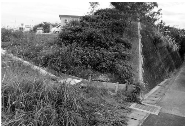
町道7号線現場の様子
