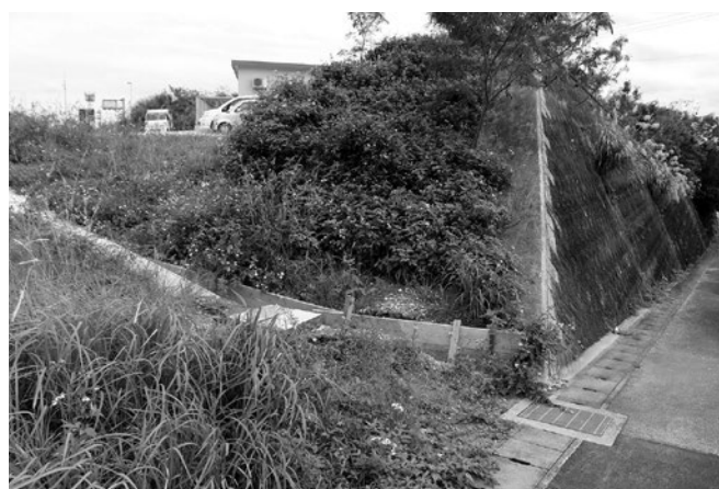
町道7号線現場の様子
