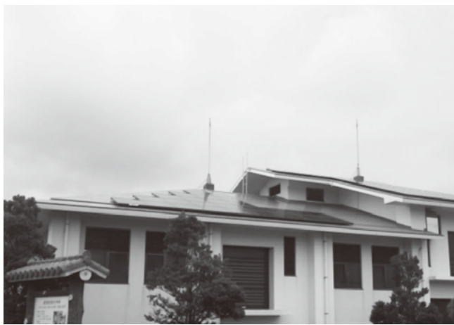
神里地区農業集落排水処理施設
