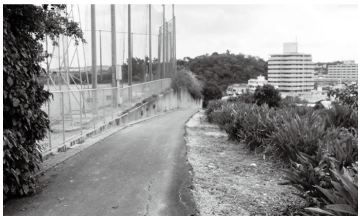
津嘉山小南側避難通路
