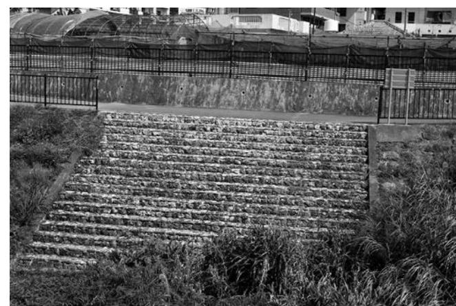
石原橋近くのスロープ（兼城）
