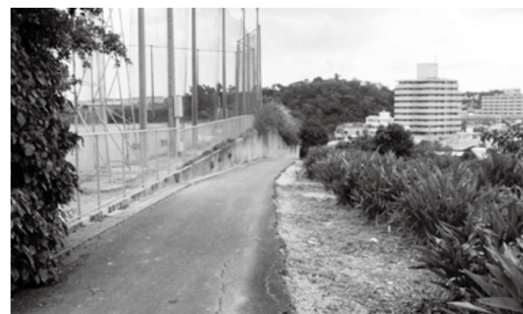
津嘉山小南側避難通路
