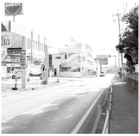
照明灯の設置要望箇所(照屋)
