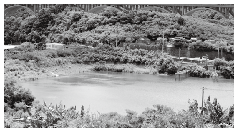
草木が繁茂している南風原ダム
