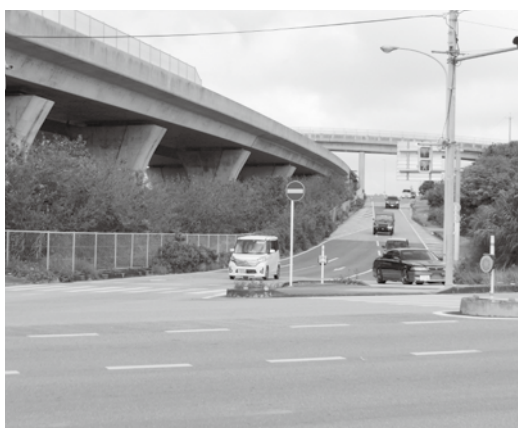
草木が繁茂する南風原南インターの状況
