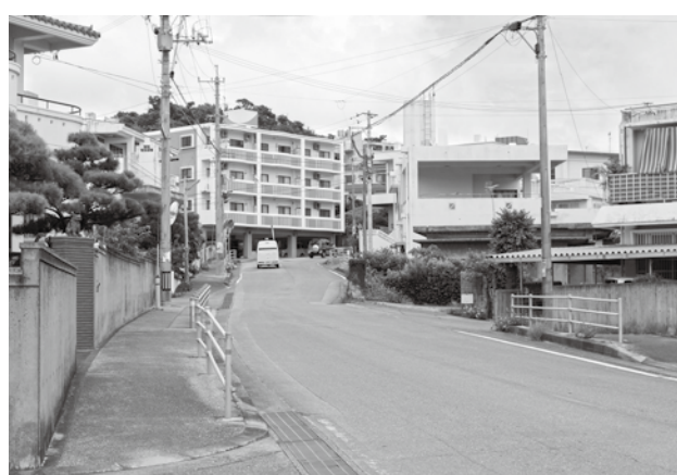
歩道設置を要望している場所（喜屋武）
