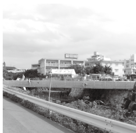
改修工事中の平原橋(宮平)
