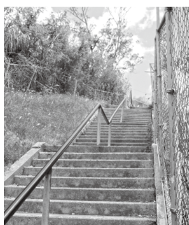
北丘小西側通路の現状
