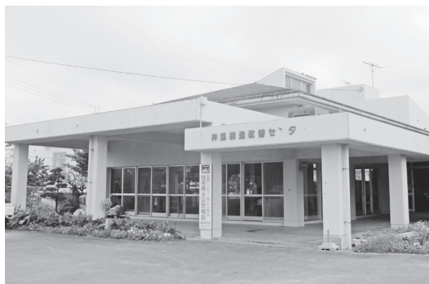
改修予定の神里構造改善センター
