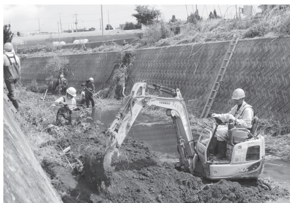
長堂川の浚渫作業
