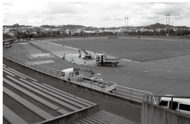
改修工事中の黄金森陸上競技場
