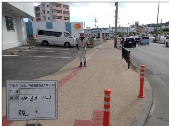
●津嘉山西線歩道整備状況(津嘉山574-1番地付近)
