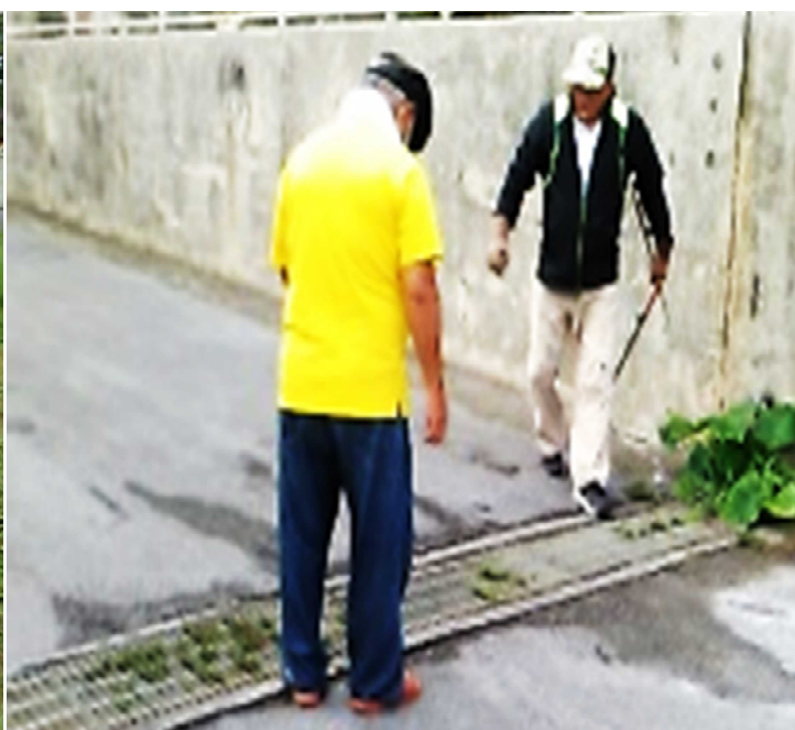
第2公園（西側）コーナー辺り、グレーチング側溝内の堆積土砂点検をしています
