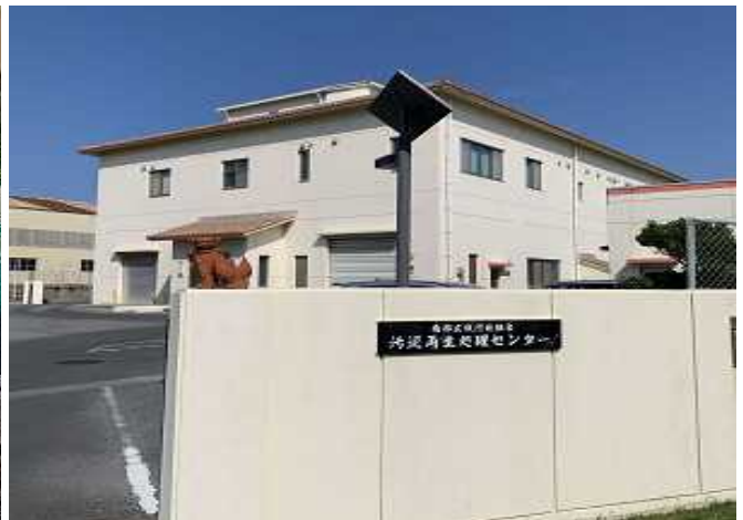
▲汚泥再生処理センター
