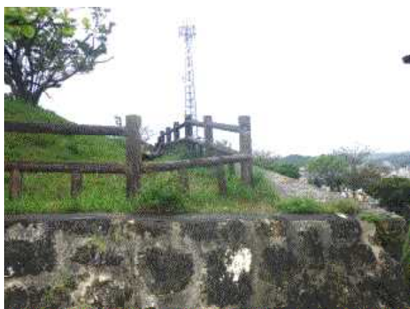
▲本部公園(転落防止柵)
