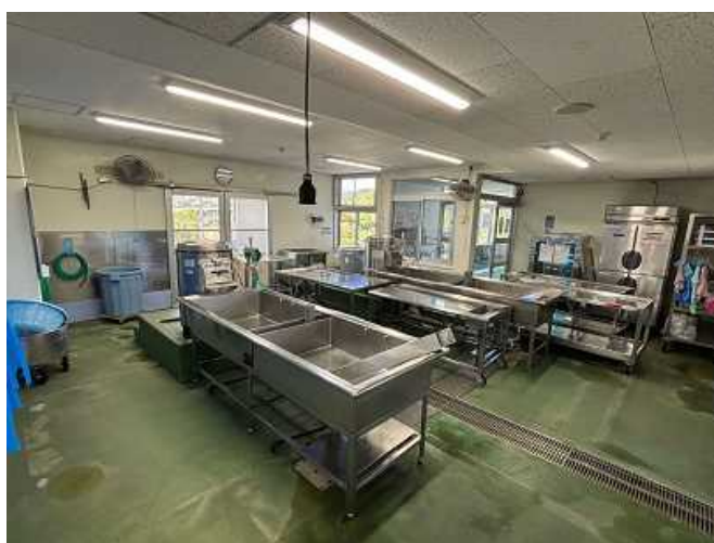
▲既存の下処理室
