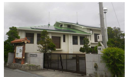
▲神里地区農業集落排水処理施設
