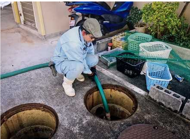
▲アパートの合併浄化槽清掃の様子
