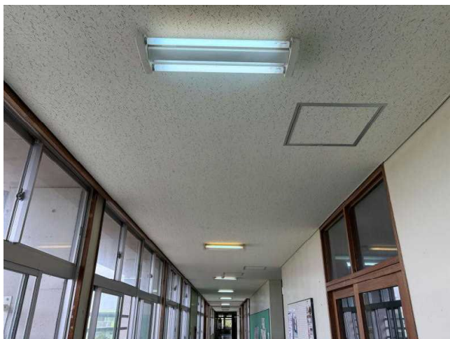
▲既存照明状況写真①
