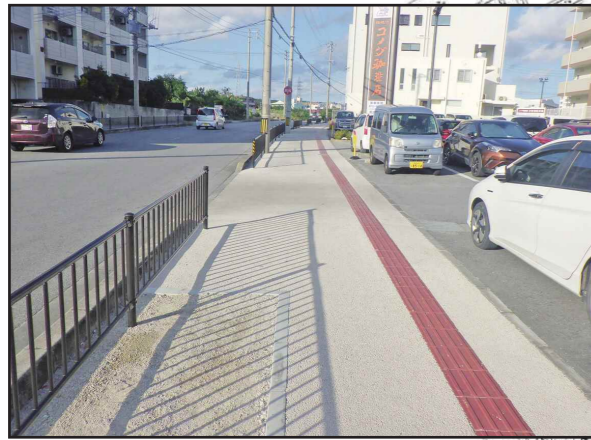
津嘉山1450-3番地周辺 工事完了
