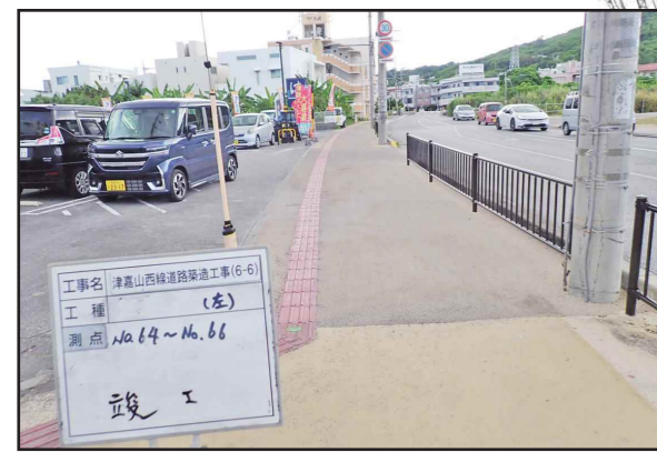
津嘉山1526番地周辺 工事完了
