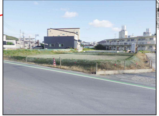
津嘉山549番地周辺 工事完了
