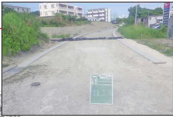
津嘉山1160-6番地周辺 工事中
