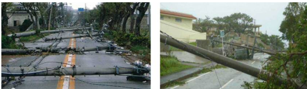
写真－1 台風による電柱倒壊状況
