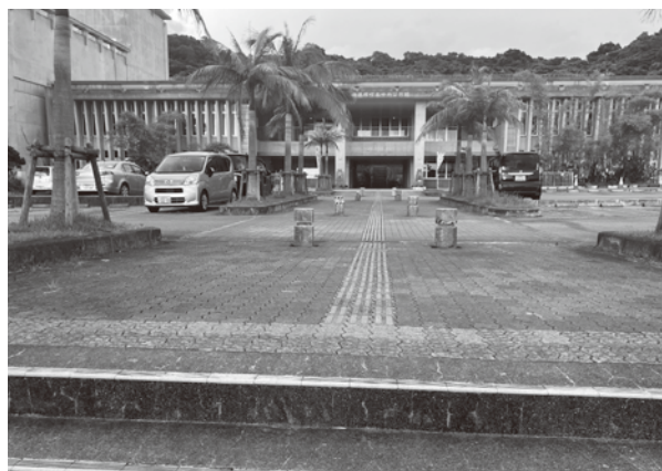
中央公民館前の通路と車止め。夜間は暗く安全でない。
