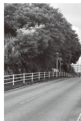
津嘉山幼稚園法面の草木
