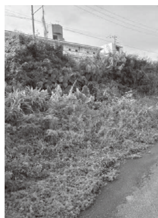
段差のある盛土
