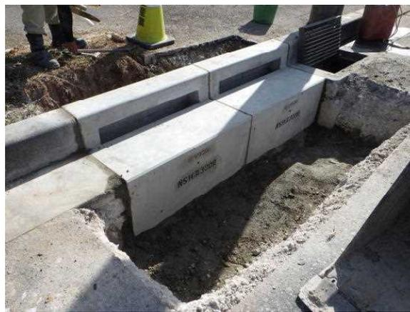
町道の側溝修繕作業状況
