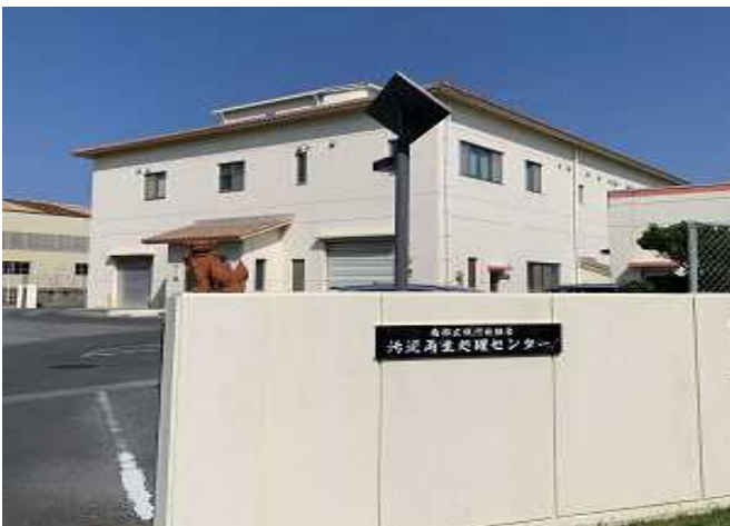
汚泥再生処理センター
