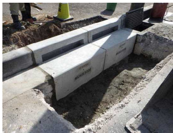
町道の側溝修繕作業状況
