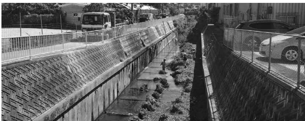
浚渫工事中の宮平川
