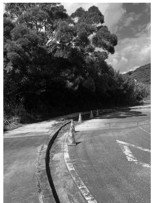
クニンドー 整備後 歩道が現れた
