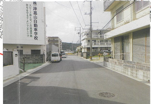
津嘉山539番地周辺 工事完了
