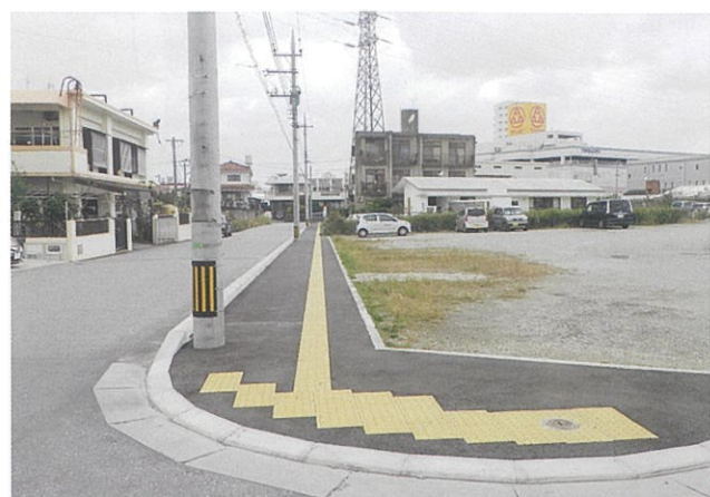
津嘉山1466-5番地周辺 工事完了
