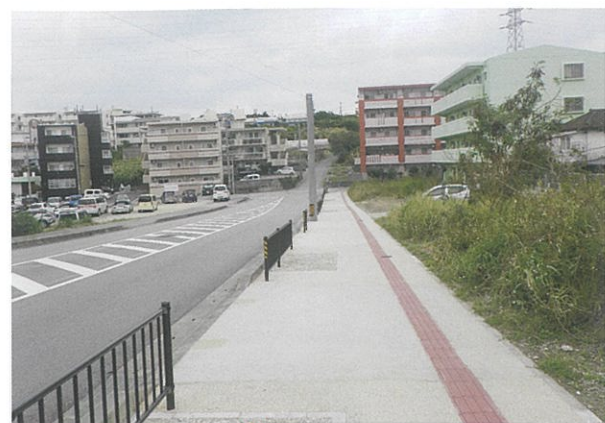
津嘉山1411-2番地周辺 工事完了
