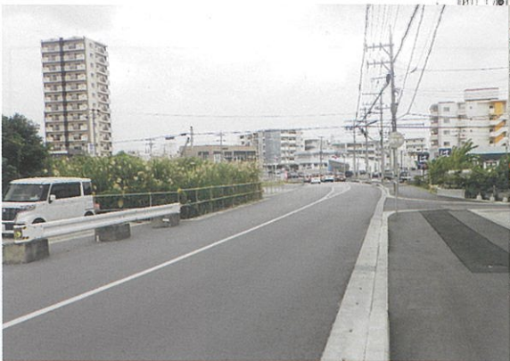
津嘉山1522-2番地周辺 工事完了
