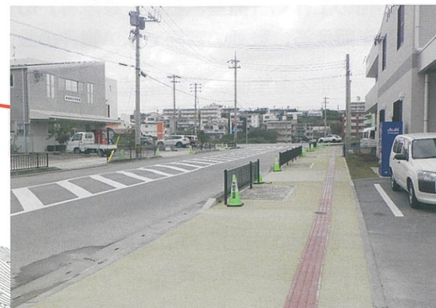
津嘉山1358-1番地周辺 工事完了
