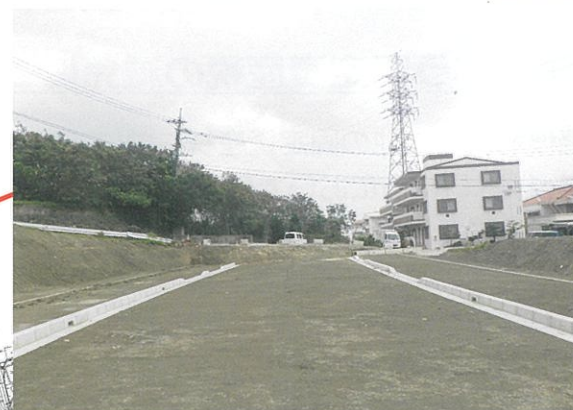
津嘉山1378-1番地周辺 工事完了
