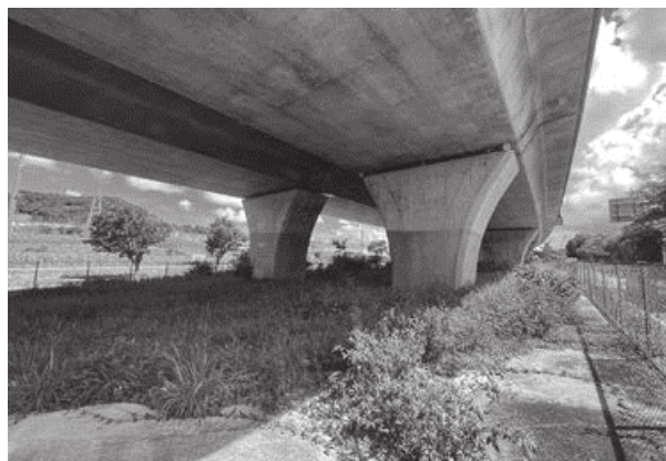
現在的那覇空港自動車道桁下空間
